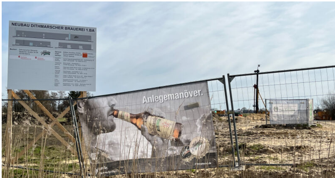
Mitten auf der grünen Wiese am nördlichen Stadtrand entsteht die neue Dithmarscher Brauerei.
